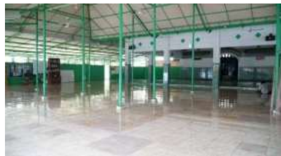
Gambar 1. Tiang-tiang besi pada bangunan masjid sebelum revitalisasi
